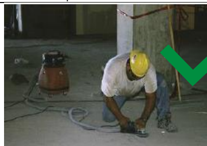
Trabajador que usa una amoladora en concreto con un sistema de recolección de polvo.
