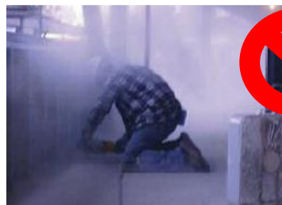
Trabajador que usa amoladora en concreto sin ningún control de polvo.
