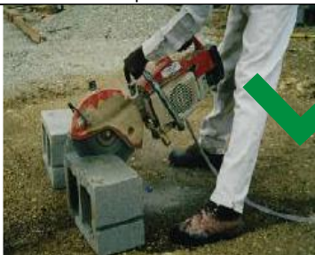
Trabajador que usa una sierra de mampostería de mano con aplicación de agua a los controles de la hoja.
