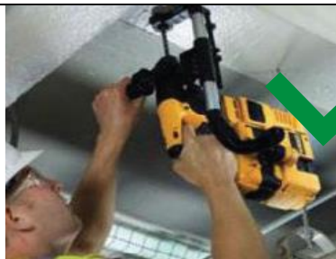
Trabajador perforando concreto con un martillo perforador equipado con cubierta y sistema de recolección de polvo.
