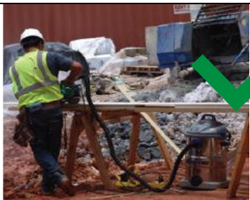
Trabajador cortando fibrocemento con una sierra de mano y un sistema de recolección de polvo.
